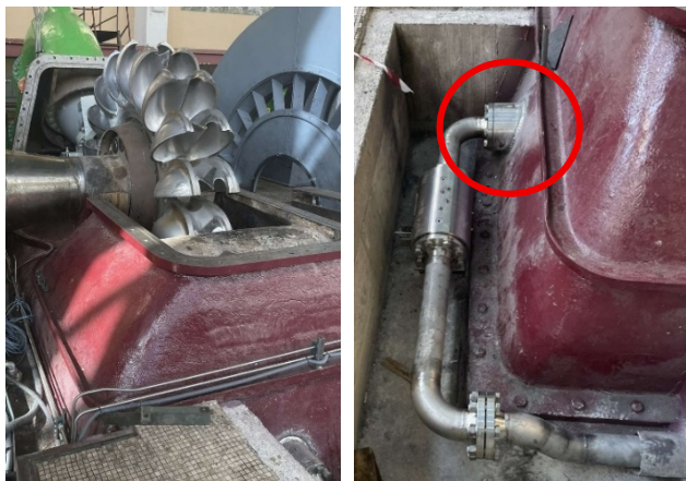
Slika 1. Radno kolo turbine i položaj kočione mlaznice u turbinskom kućištu
