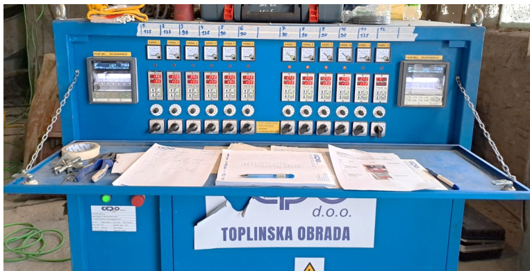
Slika 2. Kontrolisano zagrijavanje zone reparacije
