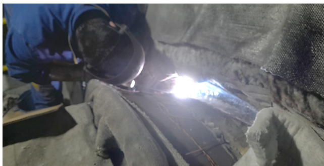
Slika 6. Proces reparaturnog zavarivanja postupkom 111
