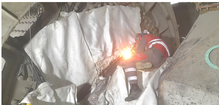
Slika 3. Proces žljebljenja
